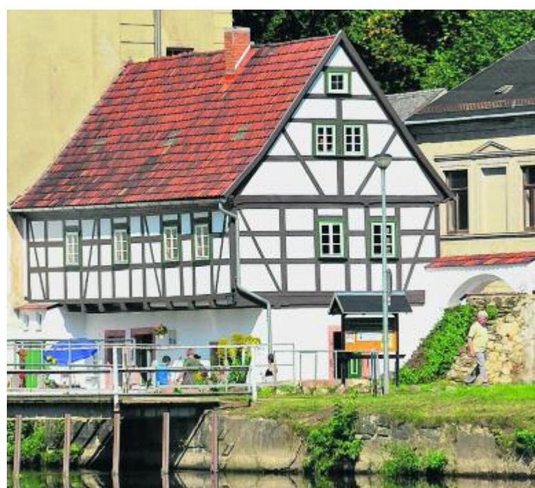
Das 232 Jahre alte Wohngebäude an der Zschopau der alten Schlossmühle in Sachsenburg wurde vom Bergbauverein saniert. Darin steht Rad-Wanderern im Zschopautal eine Informationsstelle zur Verfügung.
