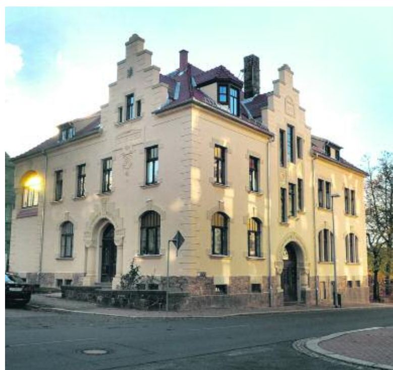
Das sanierte Pfarrhaus in Frankenberg an der Ecke Schulstraße und Winklerstraße. FOTO: FALK BERNHARDT
